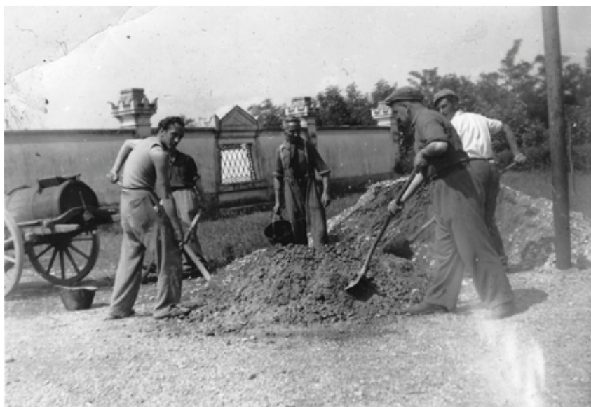
Lavori al vecchio Cimitero - Maggio 1950
